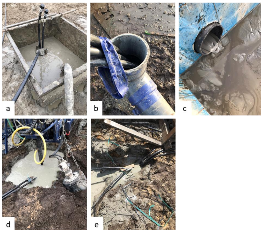
Figuur 4-15: Situatie van het boorgat tijdens het aanvullen. a) Spoelbak in Weesp, b) T-stuk in Eerbeek waarvandaan het aanvulmateriaal stroomt naar c) een spoelbak. d) Spoelgat in Bergen op Zoom e) Spoelgat in Etten-Leur.
